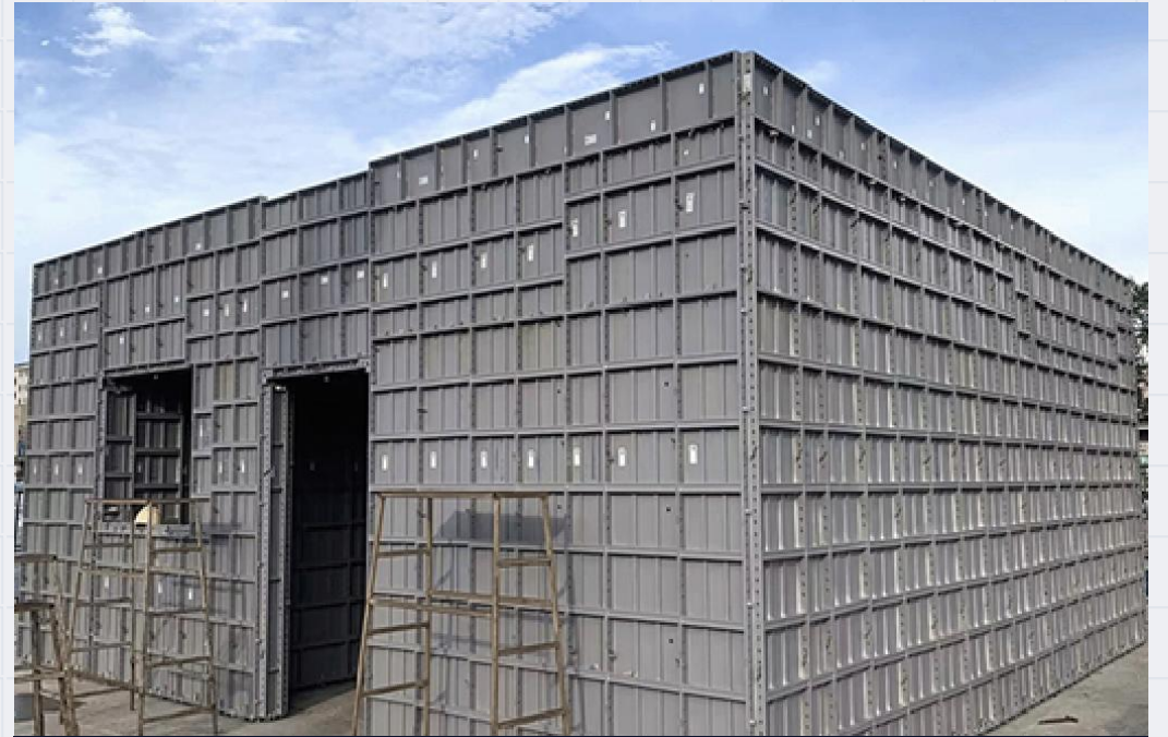
실제 건설 현장에 조립된 알루미늄 폼워크(AL-Form) 시공 전경
